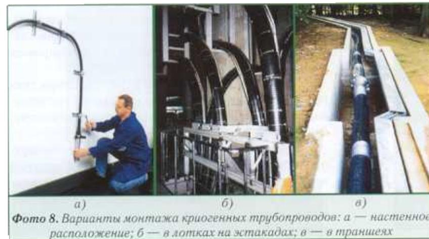
Фото 8. Варианты монтажа криогенных трубопроводов: а — настенное расположение; б — в лотках на эстакадах; в — в траншеях
