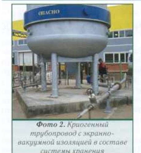
*Фото 2. Криогенный трубопровод с экранно-вакуумной изоляцией в составе системы хранения*
